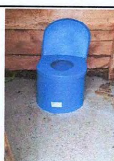
Foto 18: Colocación de torta de cemento, sustrucción de letrina de cemento a plástico.
