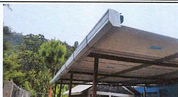
Foto 14: Sustrucción de Tubo Pvc 3" a Canal de Metal. 10mts. Largo.
