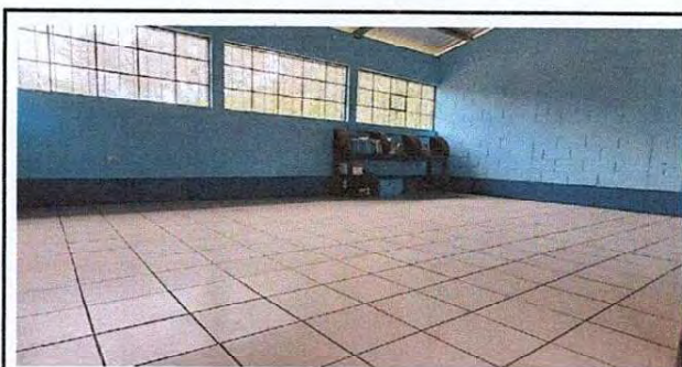
Foto 6: Sustitución de piso de cemento por ceramico. Modulo de Sexto Primaria. 6.75x5.75
