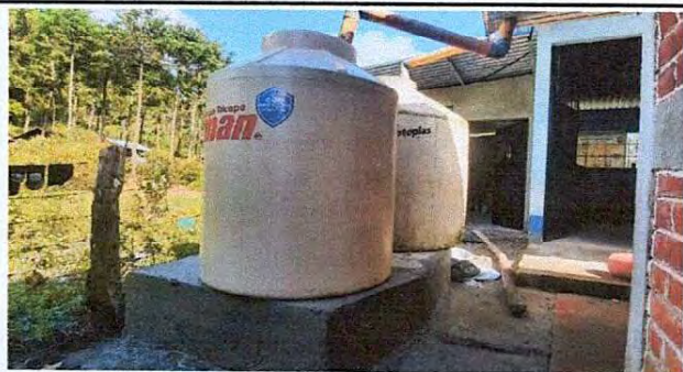
Foto 13: Sustrucción de depósito de Agua Tinaco, accesorios y base de concreto.
