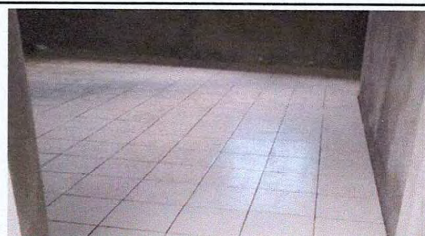
Foto 4: Sustitución de piso de torta de concreto por piso cerámico 7.50x4mts. Modulo Preprimaria.
