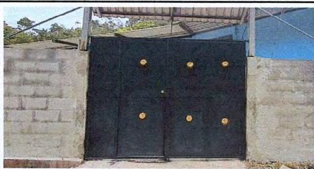
Foto 7: Sustrucción de Porton de Ingreso.
