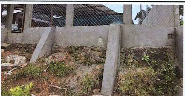
Foto 11: Reforzamiento de columna de muro de contención.
