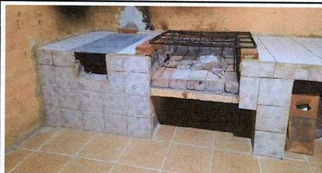
Foto 15: Sustrucción de Estufa Rural, colocación de Azulejos y Chimenea.
