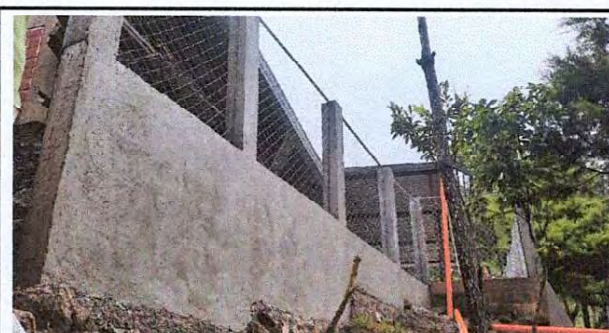
Foto 10: Colocación y Reforzamiento de muro de contención 20mts. Lineal.
