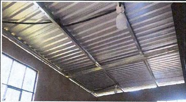
Foto 1: Colocación lámina troquelada Aluzinc calibre 26.
