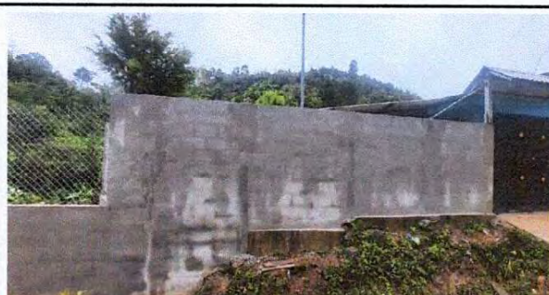
Foto 9: Frontal: Sustrucción de Malla Galvanizada por Muro perimetral de Block más repello.
