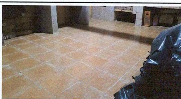
Foto 16: Colocación de piso liso a piso cerámico.
