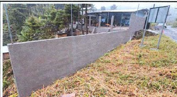
Foto 8: Lateral: Sustrucción de Malla Galvanizada por Muro perimetral de Block más repello exterior.
